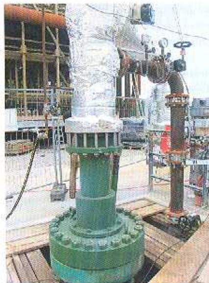
**Abb. 1.** Gesicherter Anschlussstutzen zur Entnahme des überspannten (überhitzten) Erdwärme Heißwassers von 127 °C am Kraftwerk Unterhaching. [Photo S. Brodka]
